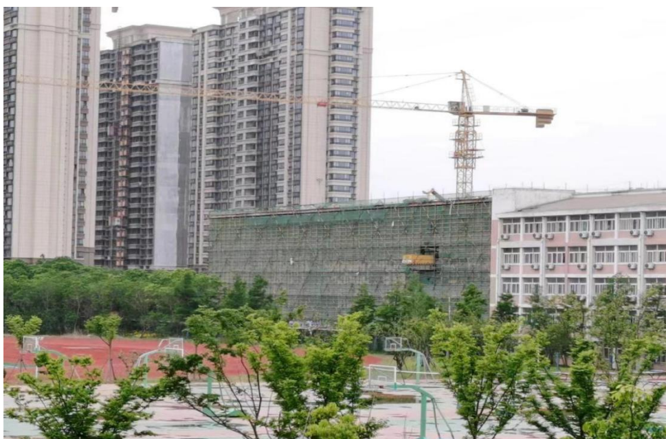
图 5 三期工程宿舍楼施工现场
