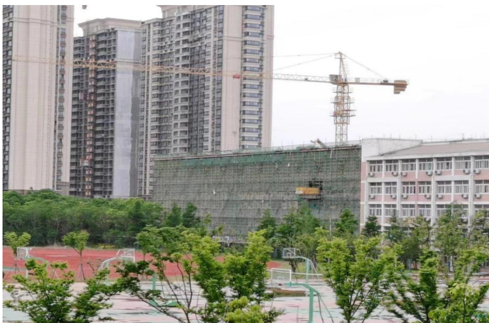
图 5 三期工程宿舍楼施工现场
